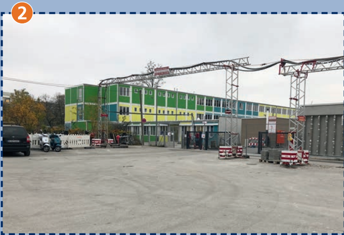
Wendehammer an der Gertrud-Grunow-Straße 51
