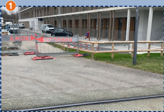
Übergang vom Trambahngleis zum Bauhausplatz
